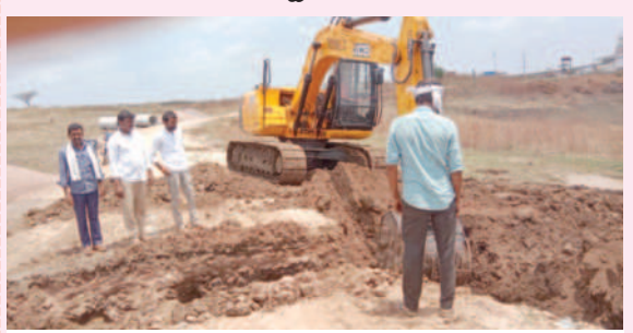
తడ్రలో రోడ్డు నిర్మాణ పనులను ప్రారంభించిన దృశ్యం
